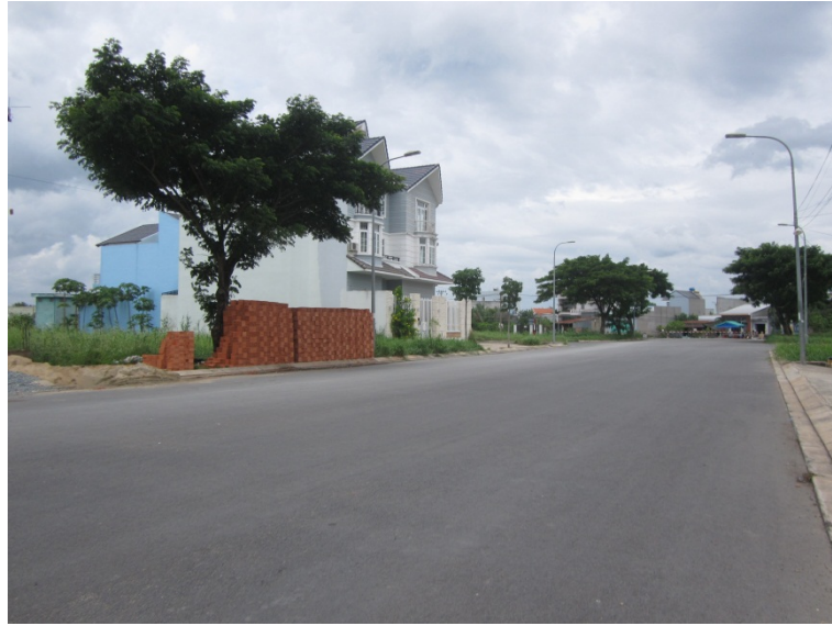
KDC Phong Phú 4 đã được đầu tư khá hoàn chỉnh về hạ tầng
