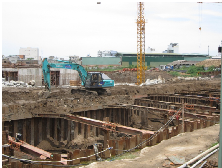
City Gate Towers dự kiến xây xong phần hầm cuối quý 3/2015
