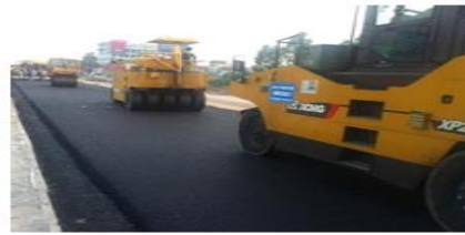
Thi công – xây lắp
