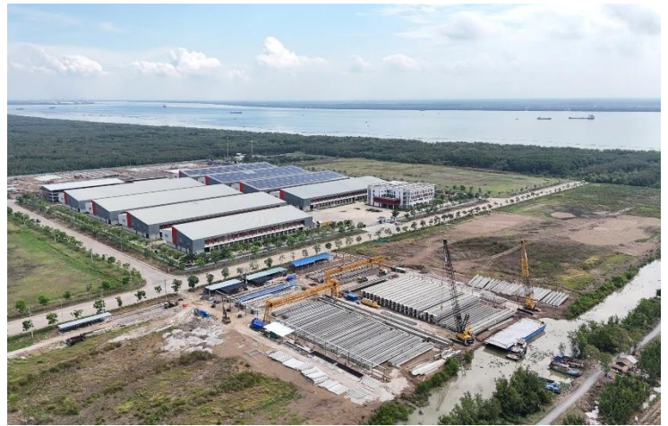
Hình 9: Cụm công nghiệp Gia Thuận của THG
